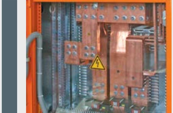
В отсеке перекрестного соединения проводов прокладываются кабели полевых шин, цепей управления и коммуникаций между шкафами.
